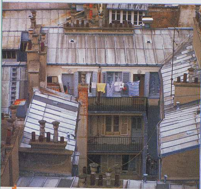
1 Toitures en zinc.
